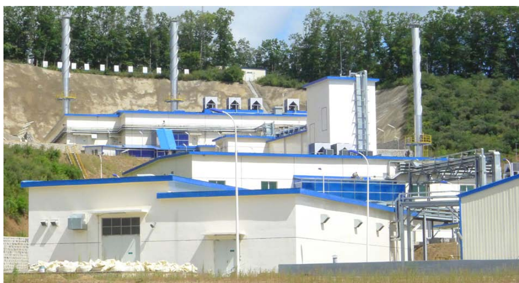
图 23 吉林敦化哈尔巴岭日遗化武挖掘回收设施
